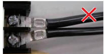
Achten Sie beim Anschließen der Kabel an die Masseanschlussklemme darauf, dass keine anderen Teile als der Quetschkabelschuh (z. B. Kabeladern und Verschraubungen) in der Klemmenbefestigung eingeklemmt werden.
